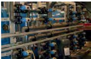
Meriveden esisuodatinlaitteistoa
