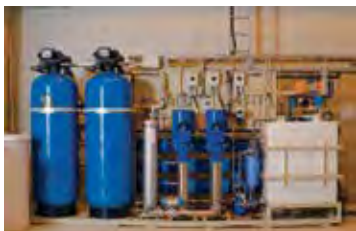
Voimalaitoksen vedenkäsittelylaitteistoa
